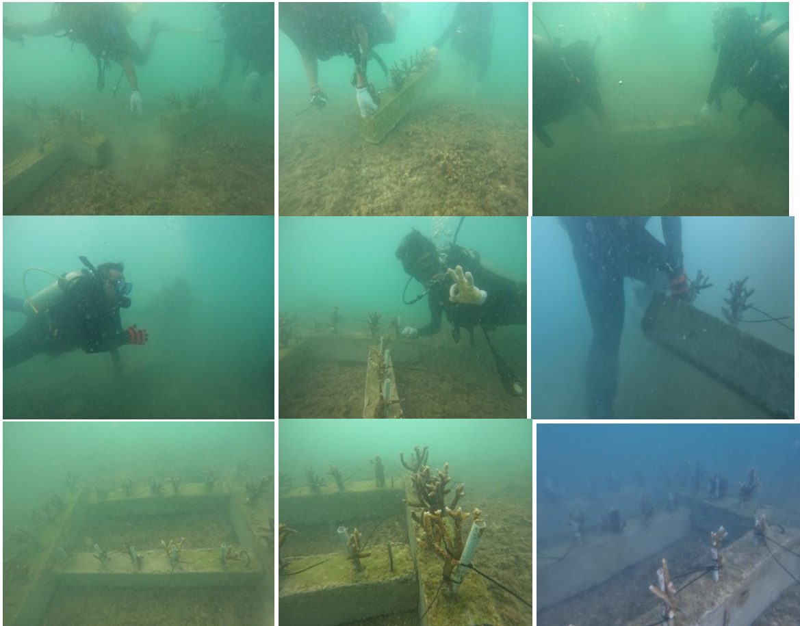
Gambar 1. Kegiatan rehabilitasi melalui restorasi ekosistem terumbu karang menggunakan terumbu buatan media balok beton
